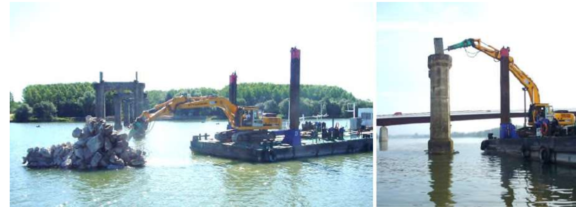
Fig. 121. Exemple de démolition de piles en rivière
