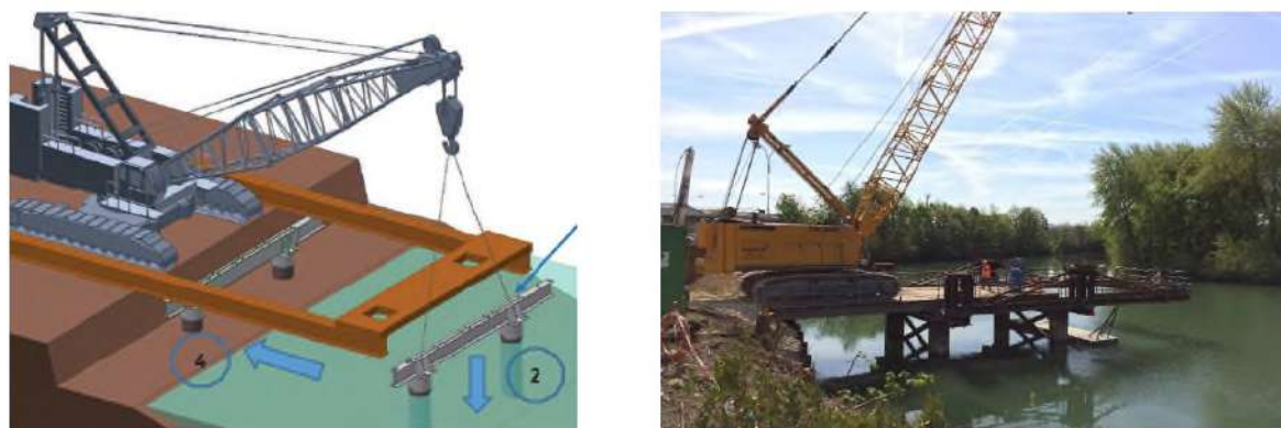
Fig. 119. Principe de construction d'estacade lourde
