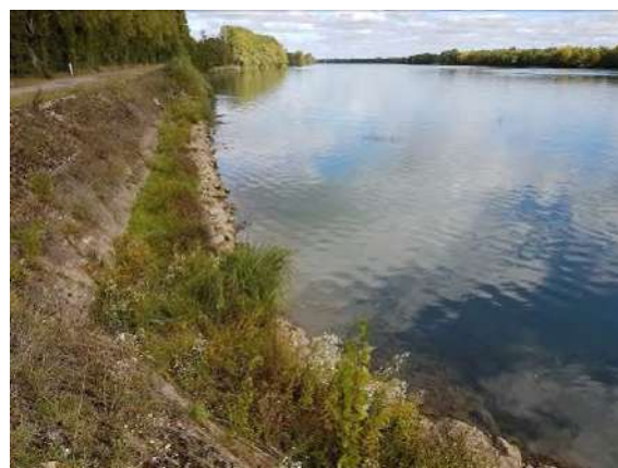
Berge aménagée limitant la continuité de la sous-trame des milieux humides (Source : IEA)
