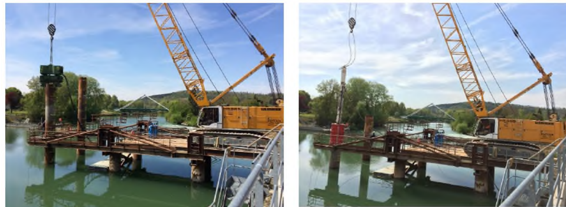
Fig. 120. Exemple d'estacade en cours de réalisation
