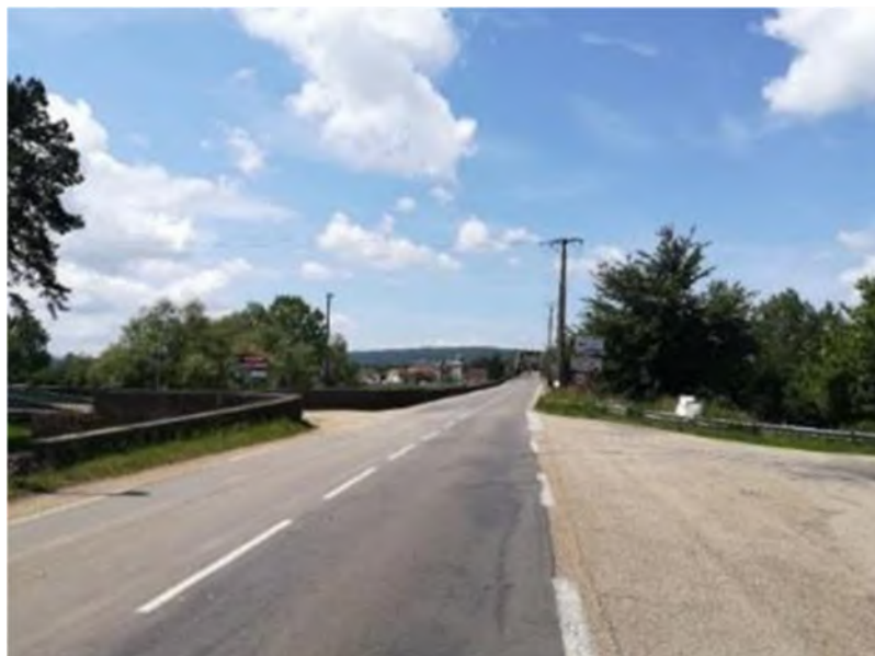
Fig. 88. Vue vers le pont de Fleurville depuis la RD933a - rive gauche (source : Artelia)
