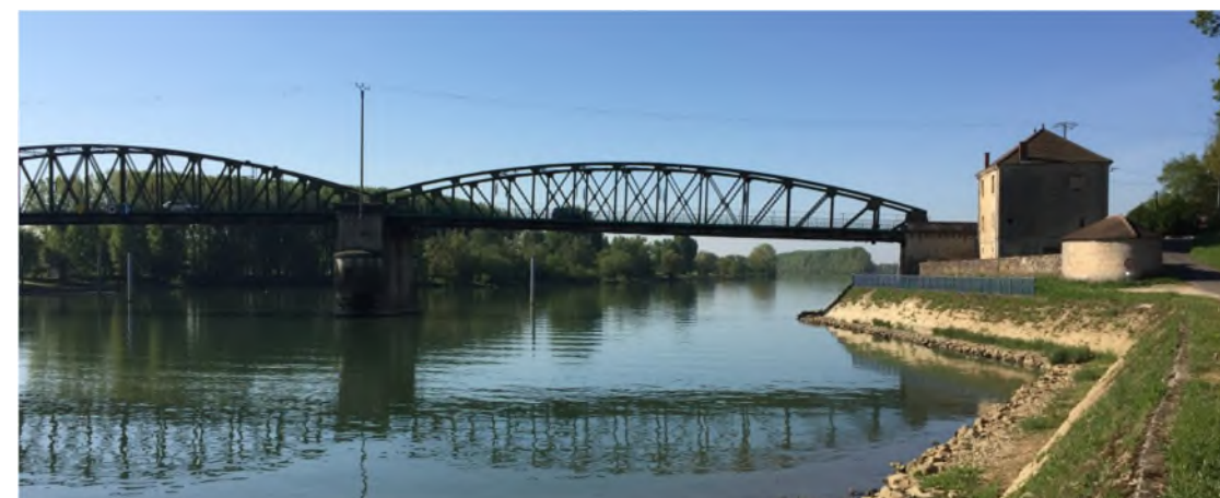
Fig. 5. Abords de l'ouvrage en rive droite côté amont
