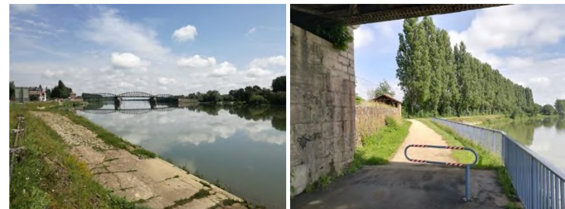
Fig. 62. Bords de Saône en amont du pont sans aucune végétation rivulaire et en aval immédiat du pont existant avec vue sur les alignements de peupliers en haut de berge
