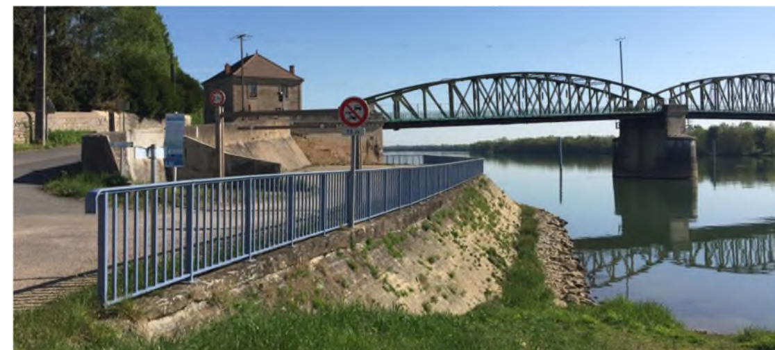
Fig. 4. Abords de l'ouvrage en rive droite côté aval
