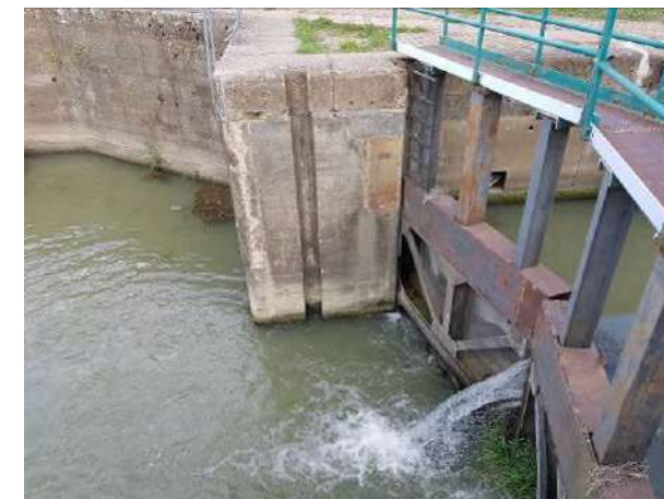
Ecluse sur le Canal du Pont de Vaux (Source : IEA)
