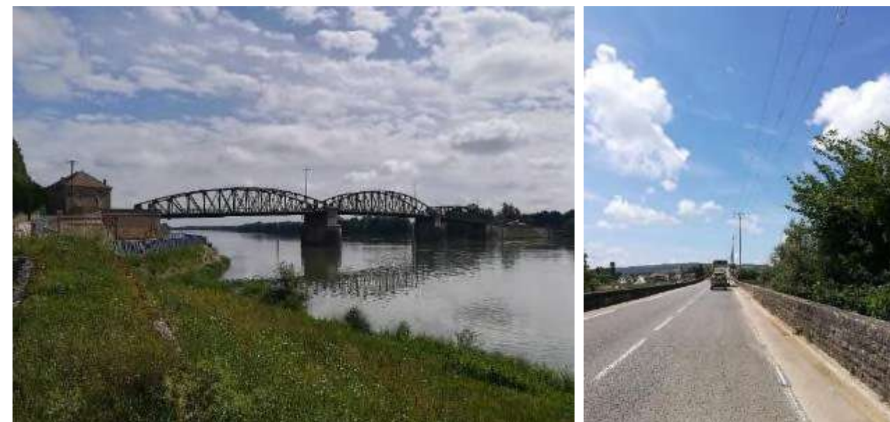
Fig. 1. Vue du pont vers l'amont, et accès depuis la rive droite (Artelia, 2018)
