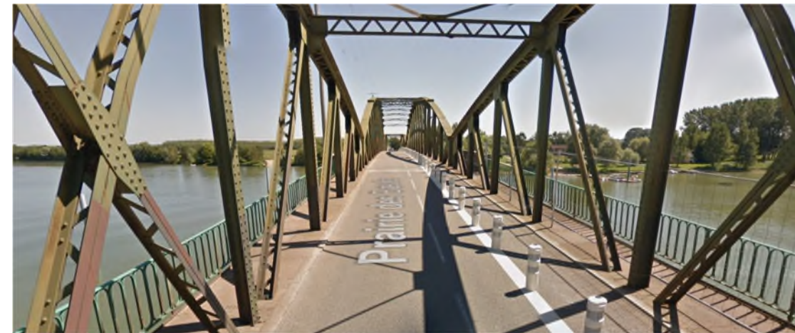
Fig. 3. Vue depuis la chaussée de l'ouvrage existant
